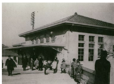
飯田町駅と牛込駅が合併し、1928年に開業した飯田橋駅（竣工時）
